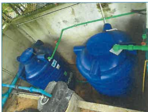
ถังเก็บน้ำขนาด 200 ลูกบาศก์เมตร จำนวน 2 ถัง
